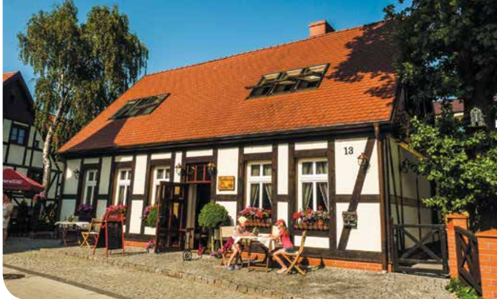
Zabudowania szachulcowe przy ul. Kosynierów w Ustce
