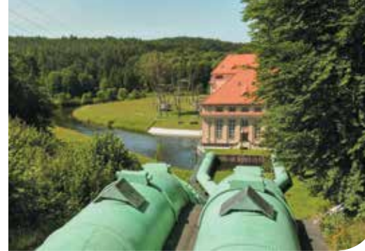
Gaźnia Mała. Pięć generatorów zamontowanych w latach 1913-1924 pracuje do chwili obecnej
