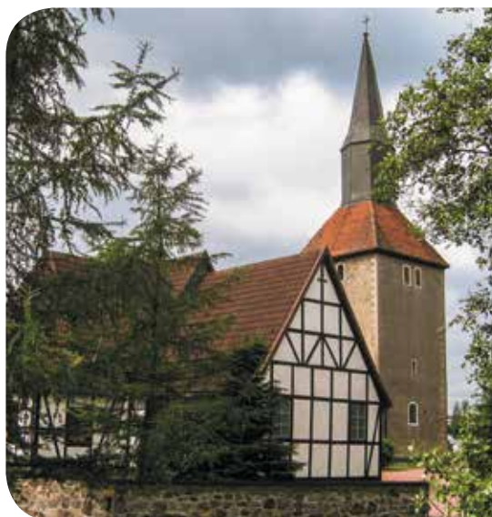
Murowano-szachulcowy kościół parafialny pw. św. Jana Chrzciciela budowany 1584 - 1604 r., a przebudowany w XVIII - XIX wieku
