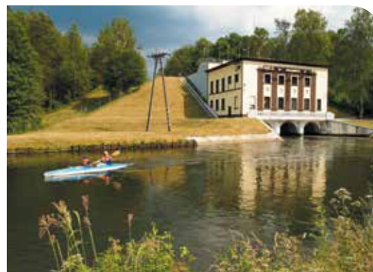
Elektrownia wodna na Słupi w Strzegominiu
