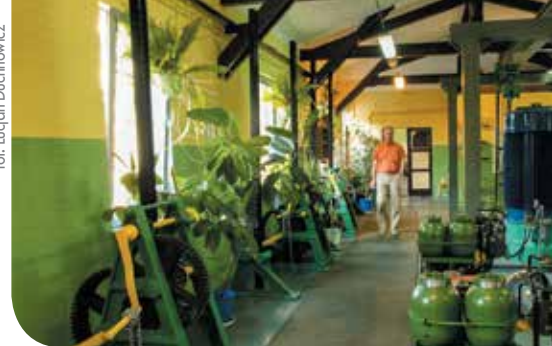
Elektrownia wodna na Wieprzy w Kępicach
