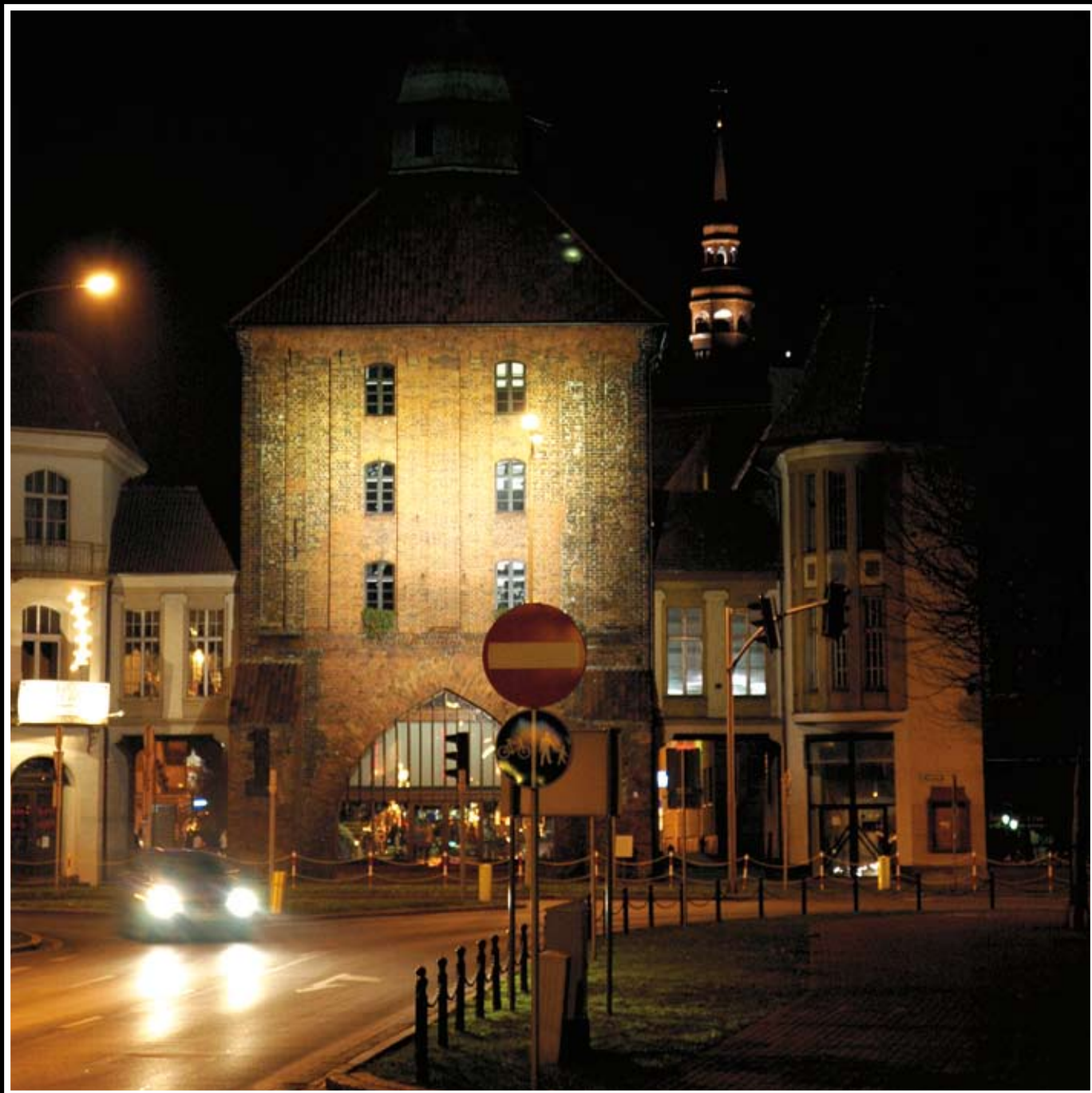
Nowa Brama nocą - widok od strony ulicy J. Tuwima.
