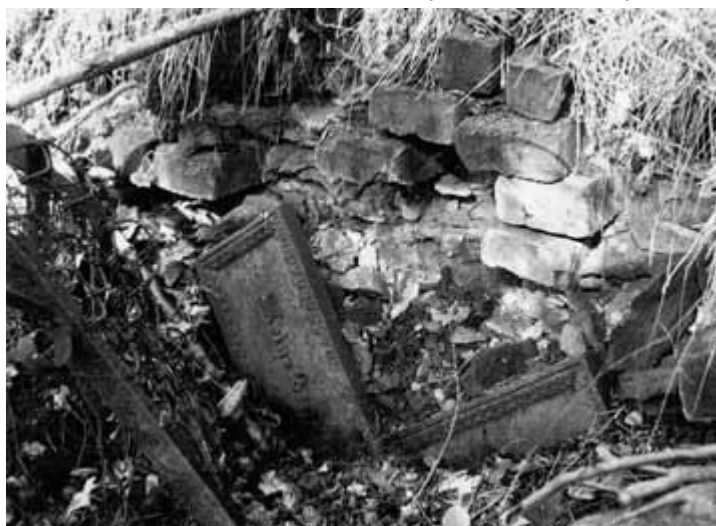
Częściowo rozebrane sklepienie ceglanych krypt. Fot. Ryszard Patorski, 1994 r.
