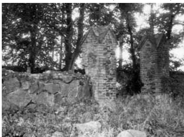
Mur graniczny z ciosów kamiennych z zaznaczonym wejściem na cmentarz. Fot. Ryszard Patorski, 1995 r.
