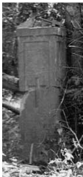
Słupek bramny głównego wejścia na cmentarz - stan przed renowacją.
