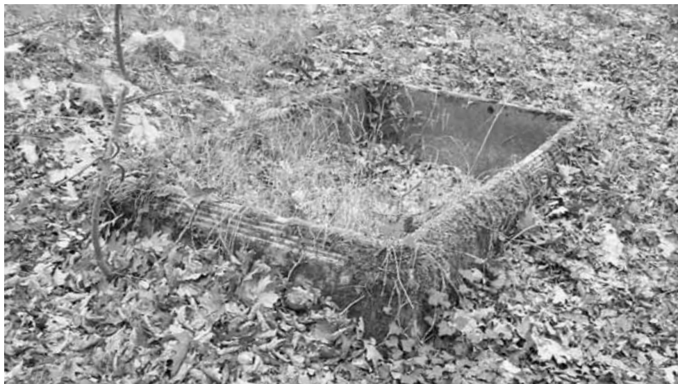
Z tego nagrobka pozostała tylko profilowana betonowa rama. Fot. Marcin Palacz, 2006 r.
