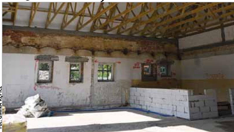
Remiza po remoncie będzie spełniała wysokie standardy stawiane tego typu obiektom.
