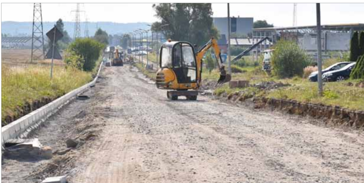
Remont ul. Transportowej zakończy się w październiku.
