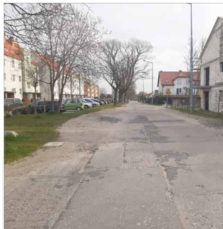
Ulica Polna od dawna wymagała modernizacji.
