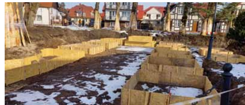
W tym miejscu stanie konstrukcja symbolizująca bryłę kościoła.
