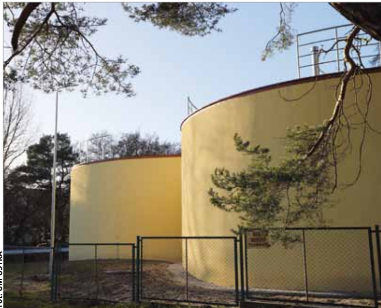
Nowe zbiorniki częściowo znajdują się pod ziemią, a wystająca ponad powierzchnię część została zabezpieczona i ocieplona.
